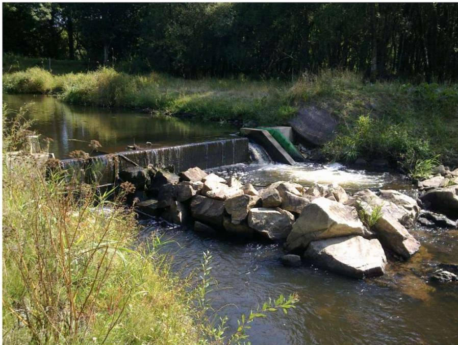
Figure 22 : Seuil dans l'Ellé à Pont Saint Yves et ouvrage de franchissement piscicole (vue aval en étiage 2016)
